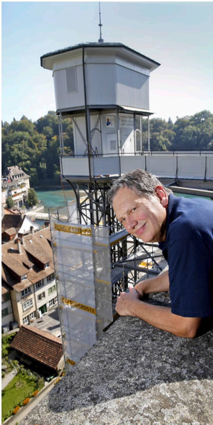
Thomas Streit fährt bis zu 300-mal im Tag rauf und runter. Weil der Mattelift saniert wird, verkehrt der Fahrstuhl derzeit aber seltener. Urs Baumann
